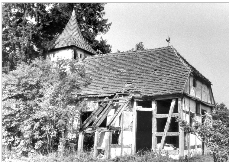
Ryc. 21. Szachulcowy kościół w Przystawach, gm. Malechowo został wybudowany „własnymi rękami i za darmo w 1780 roku przez Caspra Strehlowa (stan z 1964 roku). Fot. J. Szandomirski (archiwum WO SOZ w Szczecinie, Delegatura w Koszalinie)
