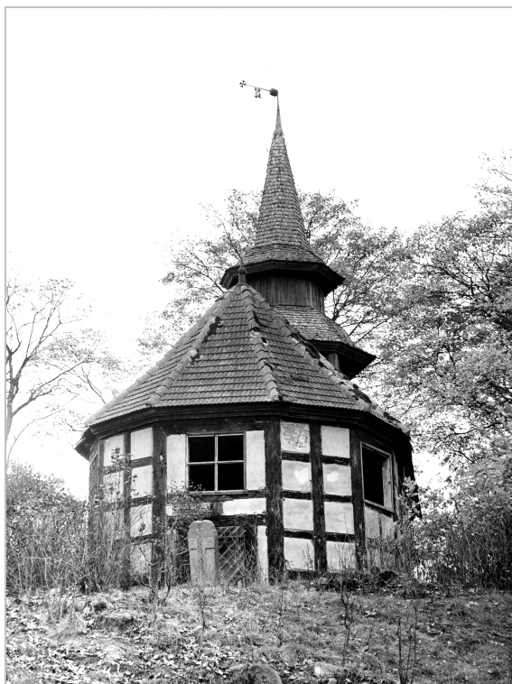
Ryc. 29. Kościół szachulcowy w Dąbiu, gm. Borne Sulinowo został wpisany do rejestru zabytków. Chociaż Minister Kultury i Sztuki nie wyraził zgody na skreślenie kościoła z rejestru zabytków, brak możliwości jakiegokolwiek zabezpieczenia i/lub użytkowania doprowadził do jego całkowitej dewastacji. Kościół zawalił się w tym samym roku (1982), w którym Wydział ds. Wyznań zezwolił na jego użytkowanie na cele sakralne (archiwum WO SOZ w Szczecinie, Delegatura w Koszalinie)
