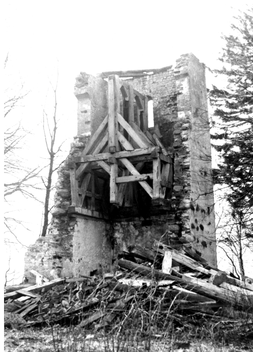
Ryc. 36. Domasławice, gm. Darłowo (stan w 1982 roku). W roku 1982 z kościoła pozostał tylko fragment jednej ściany wieży. Cegła została wykorzystana do remontu zamku w Darłowie. Fot. F.J. Lachowicz (archiwum WO SOZ w Szczecinie, Delegatura w Koszalinie)
