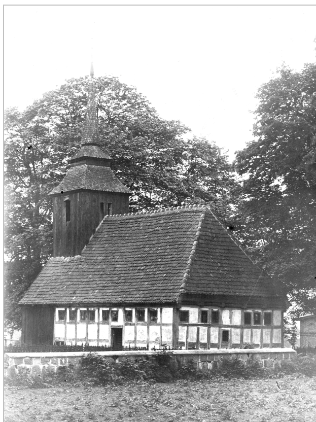
Ryc. 26. Kościół w Kłodzinie, gm. Rąbino – jeden z najstarszych (z 1588 roku) kościołów o drewnianej konstrukcji szkieletowej (stan przed 1945 rokiem) (archiwum WO SOZ w Szczecinie, Delegatura w Koszalinie)
