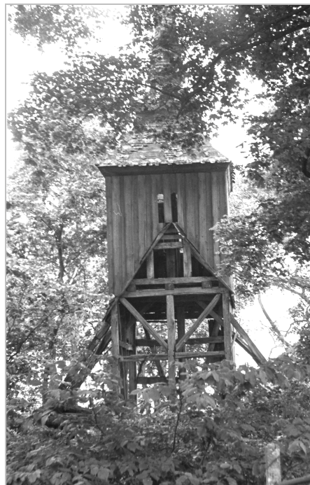
Ryc. 28. Kościół w Kłodzinie, gm. Rąbino został rozebrany „ze względu na małą wartość jako zabytek” (stan z 1984 roku). Fot. K. Gach (archiwum WO SOZ w Szczecinie, Delegatura w Koszalinie)
