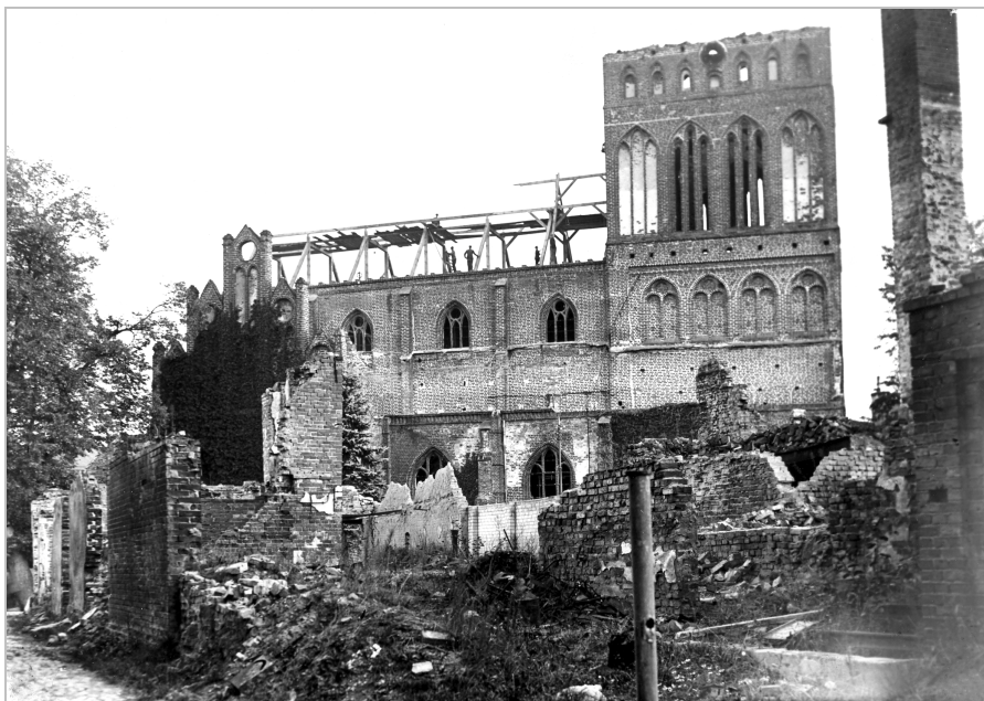
Ryc. 3. Kościół w Świdwinie w trakcie odbudowy w 1948 roku. Fot. zbiory parafii rzymskokatolickiej p.w. MB Nieustającej Pomocy w Świdwinie
