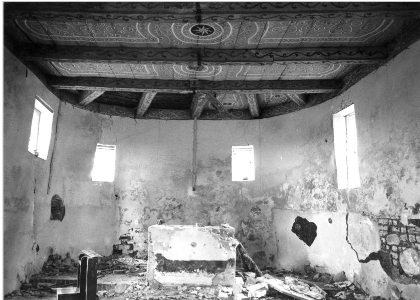
Ryc. 34. Domasławice, gm. Darłowo (stan w 1964 roku). Wnętrze kościoła z widocznym drewnianym stropem z polichromią na powale. Fot. W. Górski (archiwum WO SOZ w Szczecinie, Delegatura w Koszalinie)
