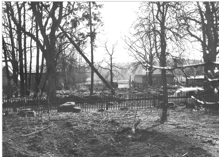
Ryc. 24. Plac po rozebraniu kościoła w Kartlewie, gm. Świdwin w roku 1970. Fot. z dokumentacji d. Wydziału ds. Wyznań
